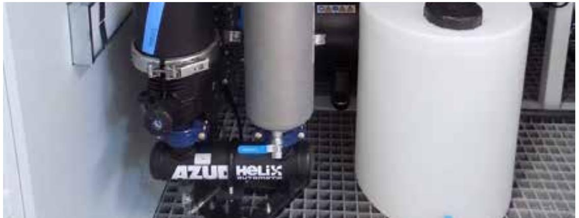
Automatische selbstreinigende Filteranlagen mit Scheibenfiltern AZUD Helix System. Steuerung der Selbstreinigung sichert das Steuergerät Azud FBC, der Typ hängt von der Filteranzahl ab. Optional 1-Filter-Modul mit Unterbrechung der Wasserzufuhr während der Selbstreinigung oder Mehr-Filter-Modul mit ununterbrochener Wasserzufuhr. Für gegebenes Projektes empfehlen wir die optimale Filteranlage.
